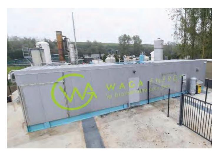
BIOGAS: 40-50% CH $_4$  ; 0-3% O $_2$  ; 300 ppmv H $_2$ S ; 5-20% N $_2$  600,000 TONS OF WASTE PER YEAR
