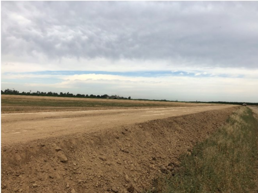
Figure 3-6. Los Robles site - Photo No. 2
